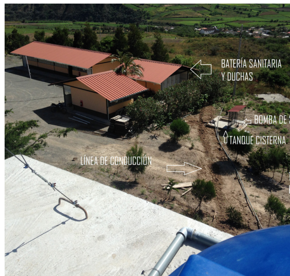
Construcción de sistema de distribución de agua.
