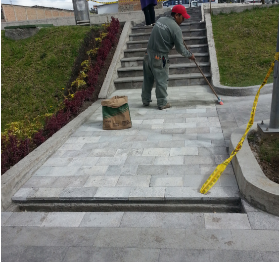
Instalación de piedra buzardeada en caminerías del Campus Universitario.
