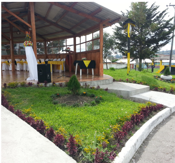
Construcción del Bar de Tropa del Batallón "MAYOR GALO MOLINA" – Tulcán.
