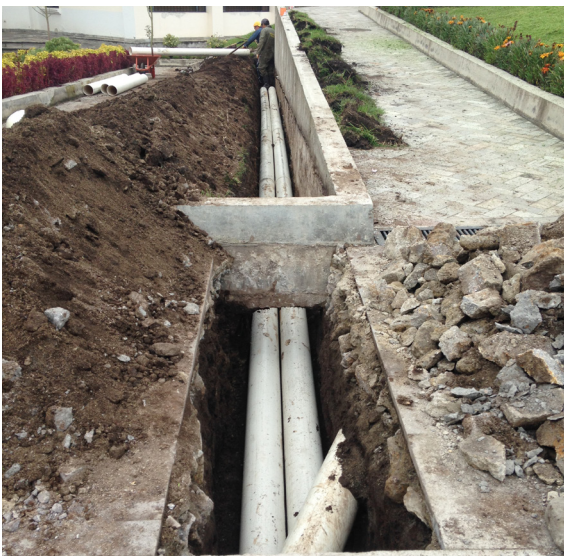
Construcción de canalización desagüe de aguas lluvias, zona Plaza Central.
