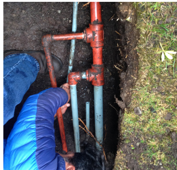
Construcción de bypass de tuberías de presión de la distribución de agua potable en el edificio administrativo..
