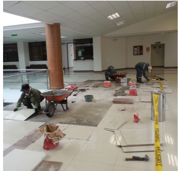
Mantenimiento de edificaciones.
