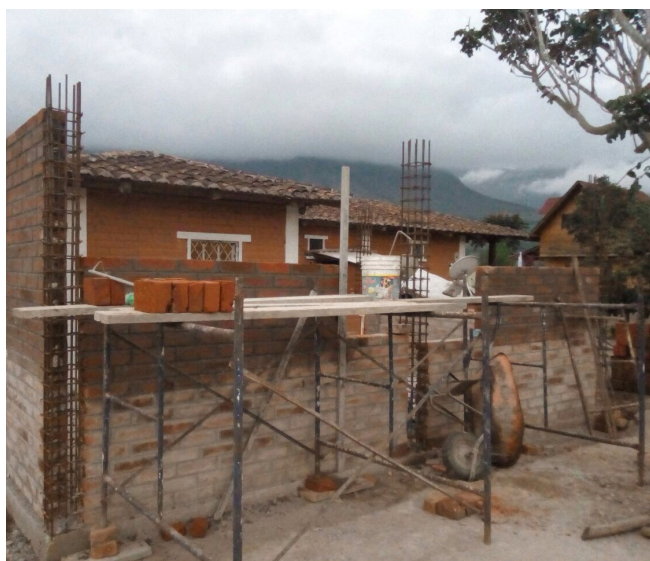
Construcción de ampliación de la casa del cuidador de la Finca Alonso Tadeo..
