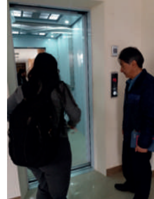
Instalación de tres ascensores para los Edificios de aulas 2, 3 y 4 del Campus universitario
