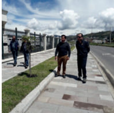
Fiscalización de la construcción del cerramiento posterior del Campus universitario
