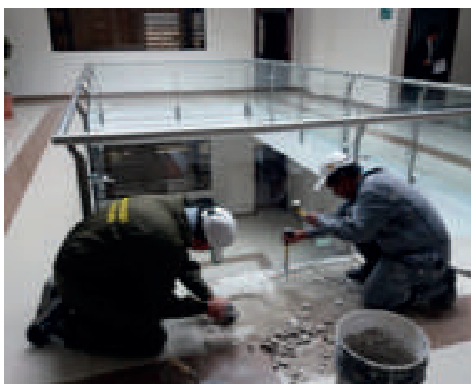
Mantenimiento de edificaciones
