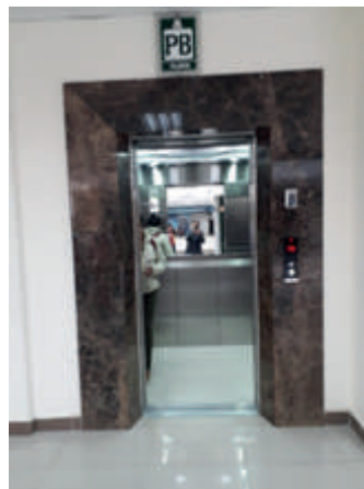
Adquisición e instalación de mármol en marcos de puertas de ascensores del Campus Universitario.
