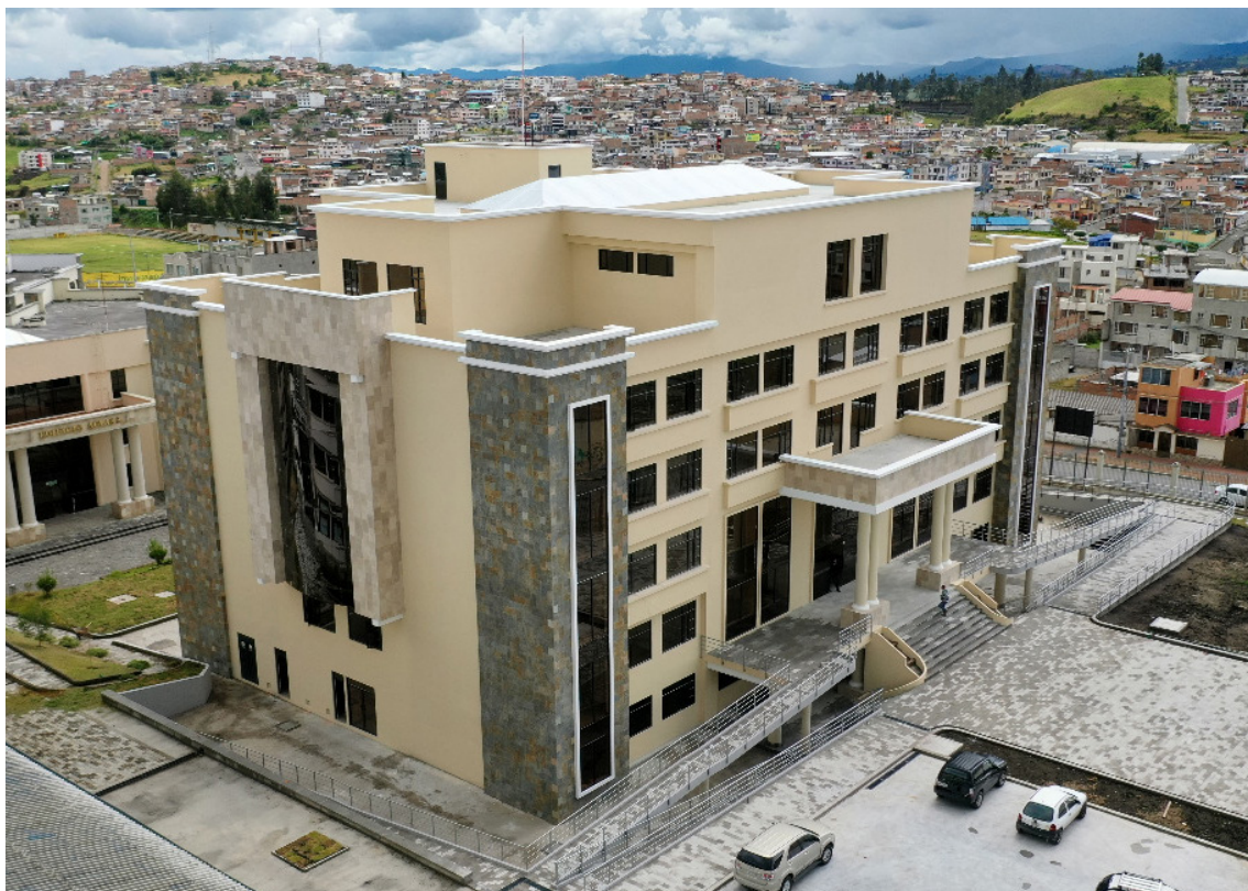
Infraestructura del nuevo edificio de Idiomas, en el que, además, funcionará la biblioteca universitaria, TIC's y los medios digitales.
