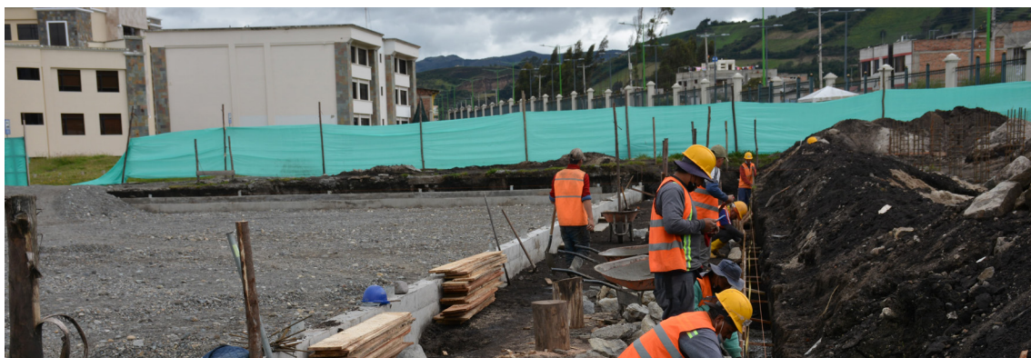
Trabajos de construcción de la cancha sintética en el campus universitario.
