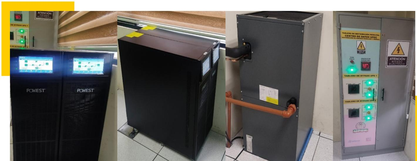
**Figura 72.** Instalación aire acondicionado y suministro de energía del Data Center – UPS
