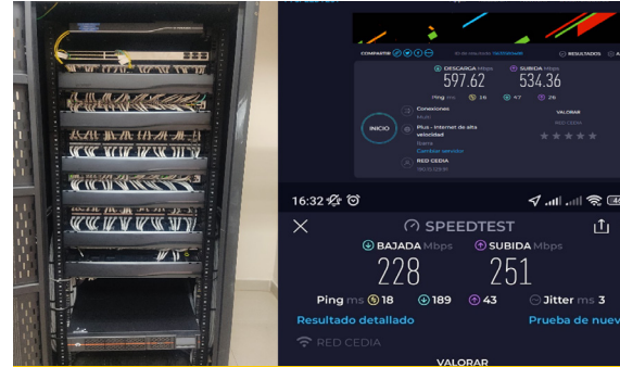
Actualización tecnológica de la red de datos cableada y WiFi - Edificios de aulas 1 y 4.
