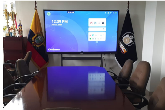
Instalación de pantallas interactivas.
