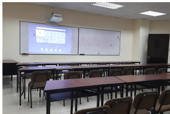
Proyectores instalados en aulas.
