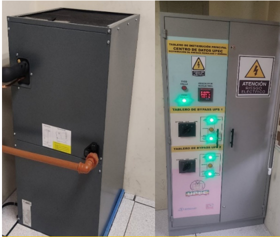
Instalación aire acondicionado y suministro de energía del Data Center – UPS.
